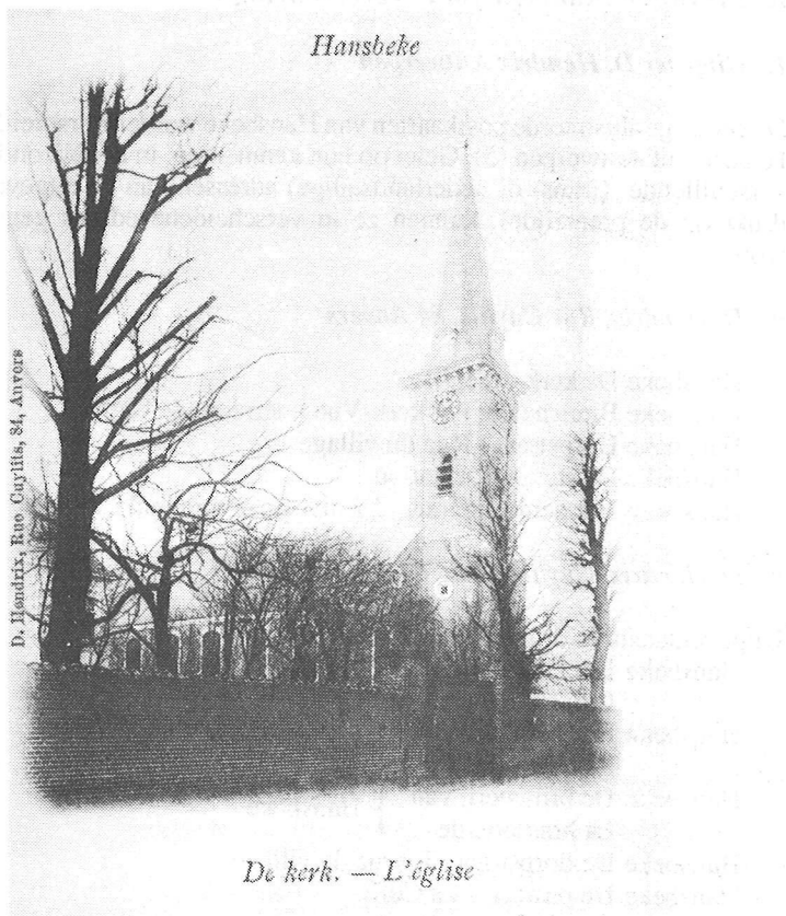
Hansbeke. De kerk-L'église Uitgever: D. Hendrix, Rue Cuylits, 84, Anvers (1900) (Verzameling Julien De Baets, Hansbeke)
